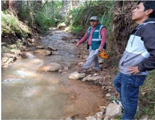
IMAGEN 01: SE MUESTRA EL ESTADO EROSIONADO DE LAS MARGENES DE LA QUEBRADA SULLUSCOCHA SE REQUIERE DE DE PROTECCION EN AMBAS MARGENES PARA EVITAR LA SOCAVACION
